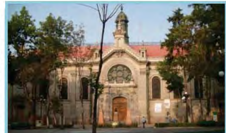
IGLESIA DEL BUEN TONO Obra del ingeniero Miguel Ángel de Quevedo, con elementos del Neobarroco y del Neorrománico. S. XIX-S. XX
