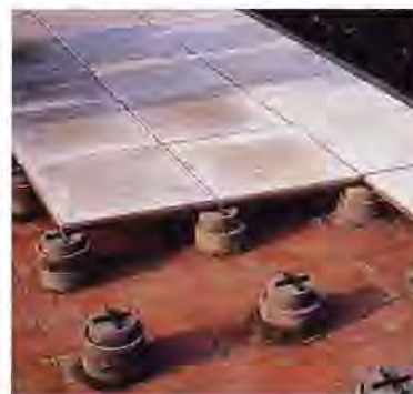
Figura 5. Solución con losa flotante
