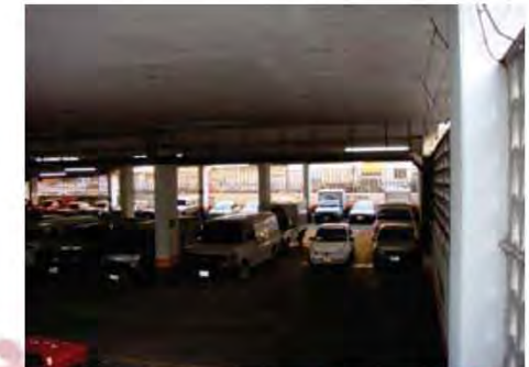
Img. 2 Vista del estacionamiento y columnas
