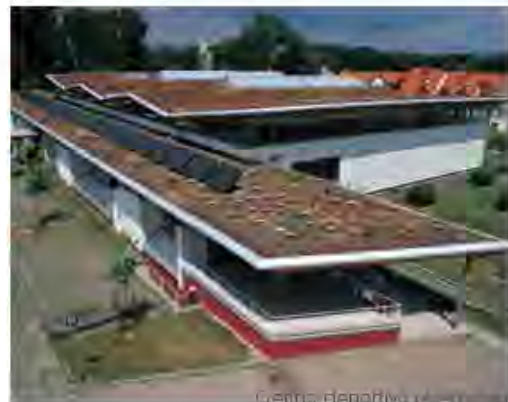
Centro deportivo y residencial
