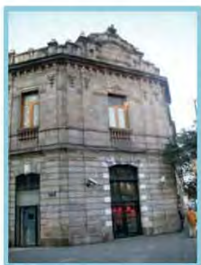
EDIFICIO DE LA CIGARRERA Las estructuras de la fábrica estaban hechas de hierro usado comúnmente en las construcciones de finales de siglo XIX y principios de siglo XX, posteriormente fue recubierta y con cantera luciendo un acabado estilo francés.
