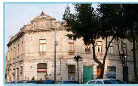
EDIFICIO DE LA CIGARRERA Las estructuras de la fábrica estaban hechas de hierro usado comúnmente en las construcciones de finales de siglo XIX y principios de siglo XX, posteriormente fue recubierta y con cantera luciendo un acabado estilo francés.
