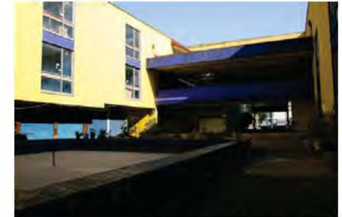
Img. 1 Vista del patio interior
