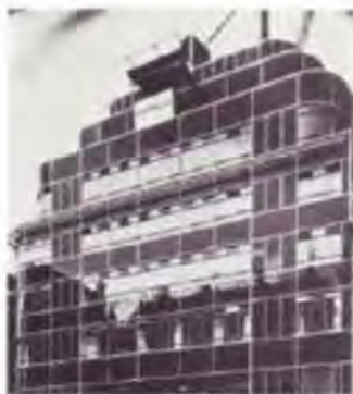
Edificio BBVA, Oiza, E. Sáenz de Oiza.
