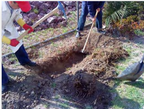
Figura 4.4. Excavación de la zanja para el humedal.
