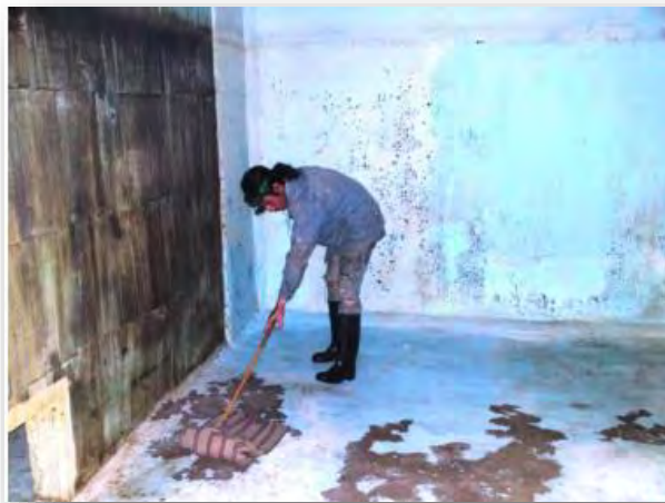
Figura. 3.3. Cisterna de Mantenimiento
