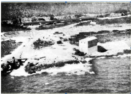
Figura 2.1 Planta OTEC de ciclo abierto desarrollada por George Claude y Boucherot en Matanzas Cuba en 1930. Fuente: Planas Juan Manuel (1930).
