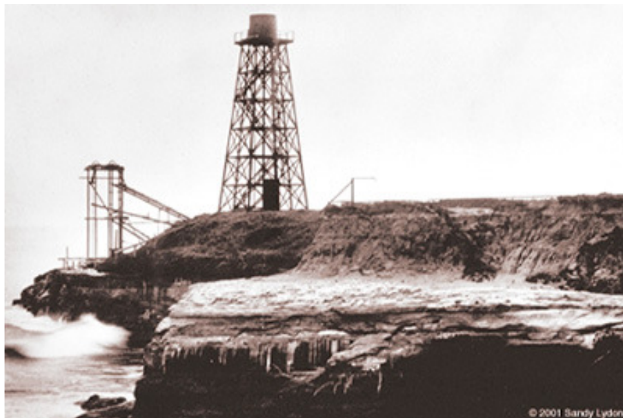
Figura 1.1. Wave Motor de los Hermanos Armstrong, en Santa Cruz California USA, año 1898. Fotografía de Sandy Lydon 2001 (Sentinel S. C. 1898).
