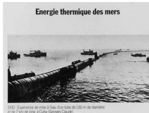
Figura 2.1 Planta OTEC de ciclo abierto desarrollada por George Claude y Boucherot en Matanzas Cuba en 1930. Fuente: Planas Juan Manuel (1930).
