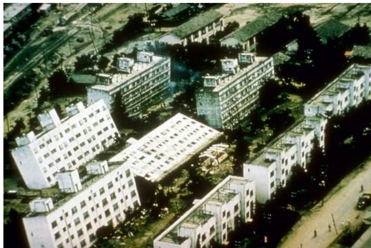
Fig. 2.2.5 Licuefacción de suelo a causa del terremoto ocurrido en Niigata en 1964
