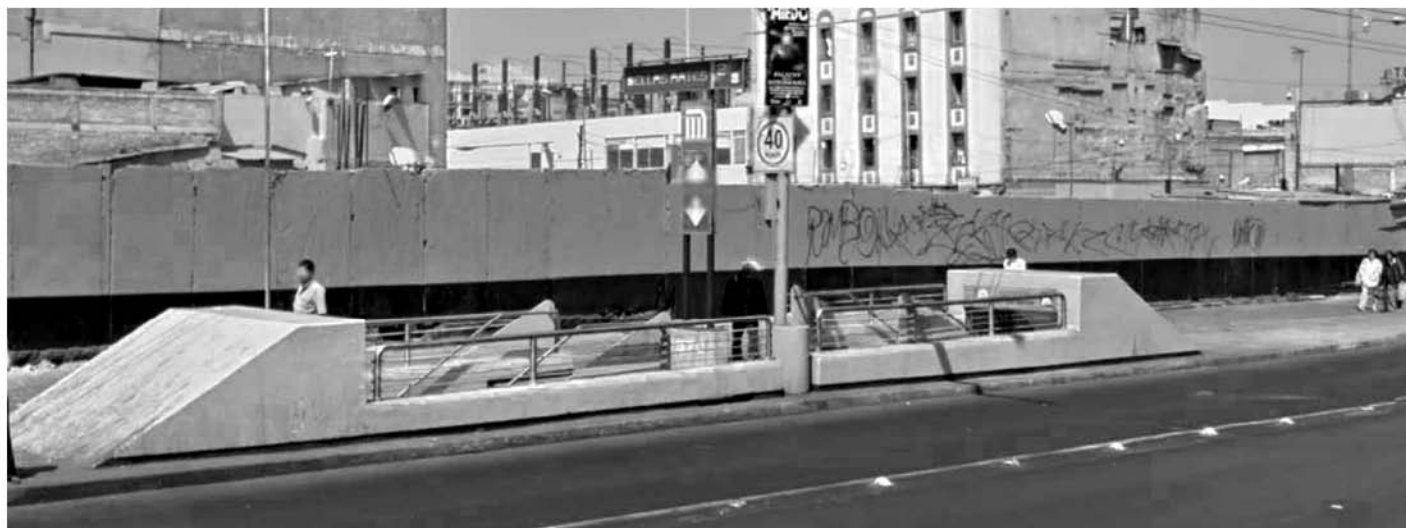
▼ ESTADO ACUTAL DEL PREDIO (VISTA SOBRE EJE CENTRAL)*
