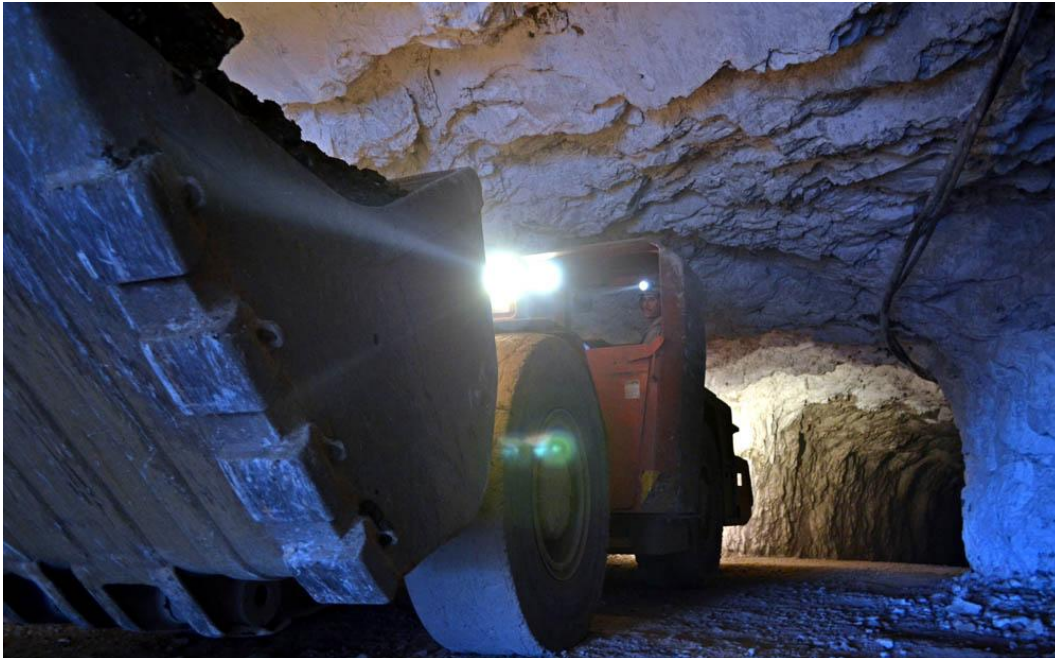
Figura 3.5 Mina San Martín: operaciones subterráneas
