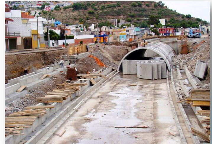
2.31 Obras de mejoramiento de drenaje municipal
