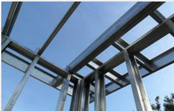
2.28 Estructura de Acero
