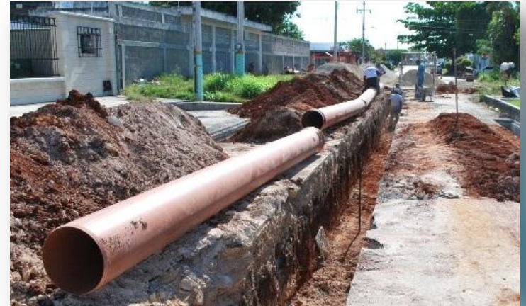
2.32 Obras de mejoramiento de drenaje municipal
