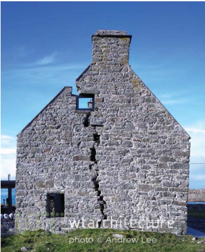
Fachada Ruinas Vista Interior
