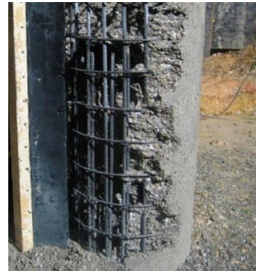
Armado y diseño de Columna zunchada.
