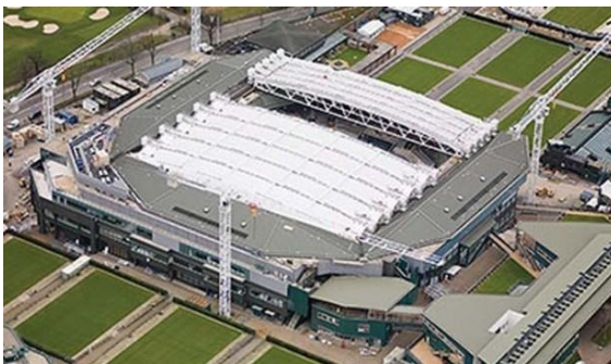
Vista satelital de la Cubierta del Estadio
