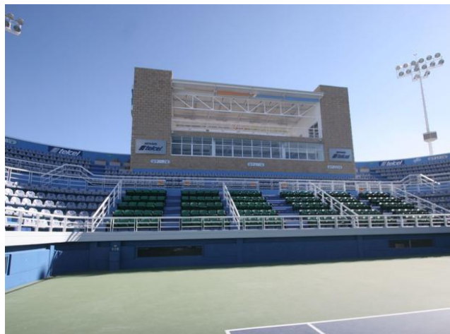
Interior de la Cancha de Tenis
