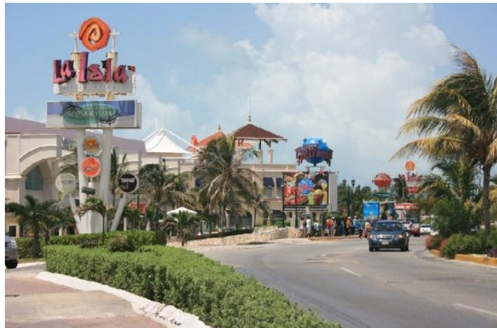
Fachada Norte Centro Comercial La Isla
