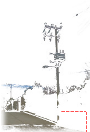
Poste con transformador ubicado sobre la calle de Francisco Sarabio
