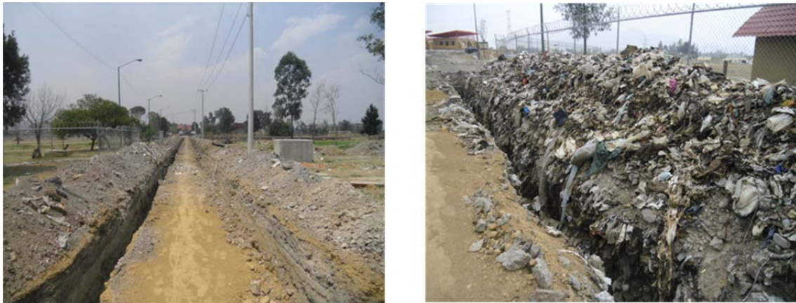
Fotografía 32: Conformación del terreno, Parque Cuitláhuac, Parque del Pueblo en 2012
