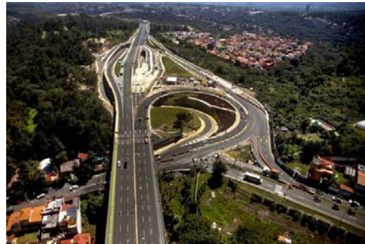
Fotografía 50: Puente Tarango de la supervía en la cima del AVA bosque de Tarango
