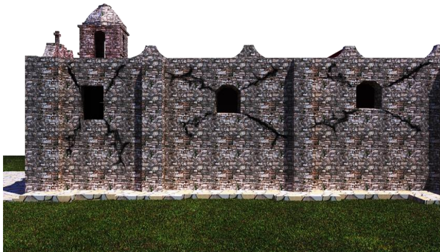
Figura 3.4 Agrietamientos por contracciones de esfuerzos debidos a los huecos de puertas y ventanas
