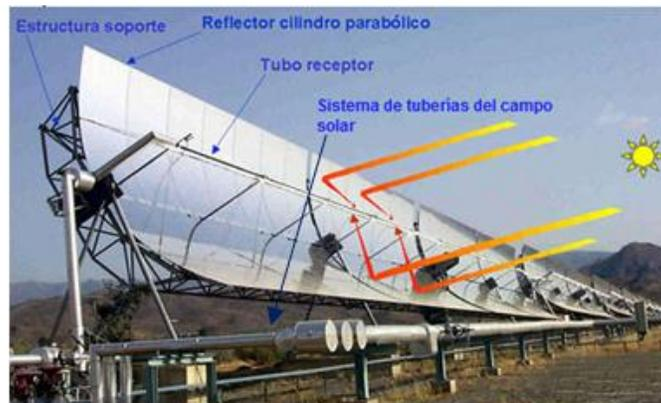
Figura 1. 12 Concentrador Cilindro Parabólico.<sup>13</sup>
