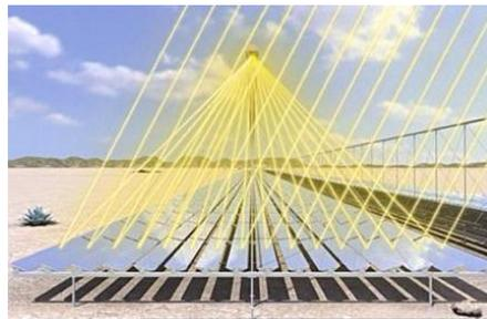
**Figura 1. 13 Concentrador FLC en la planta Puerto Errado 1 en Murcia.<sup>15</sup>**
