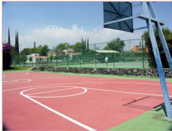
Imagen 5.4.- Pintura de cancha de concreto.
