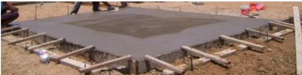
Imagen 5.2.- Cimbrado de cada tablero de la losa.
