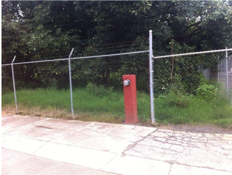
Imagen 3.17.- El terreno cuenta con las instalaciones para servicio eléctrico, sanitario e hidráulico.
