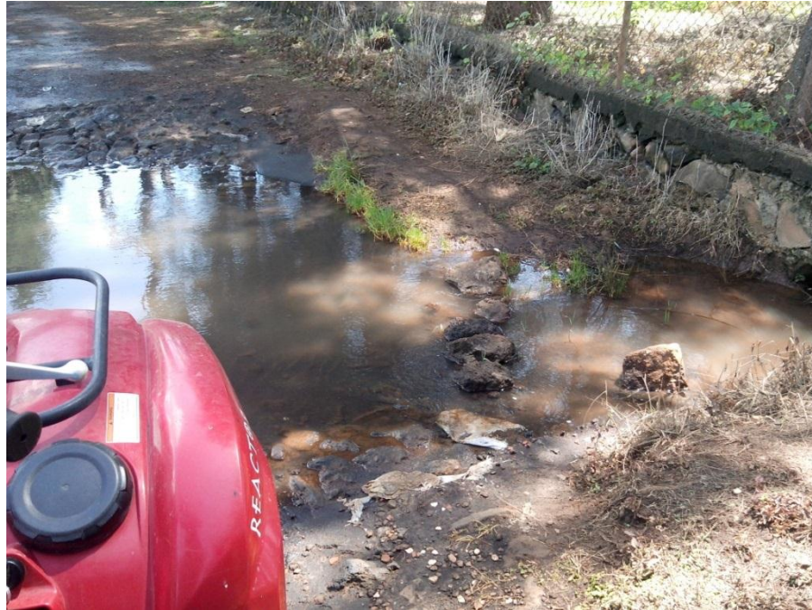
Figura 4.16. Esgurrimiento natural transversal a la vía Fuente. Propia
