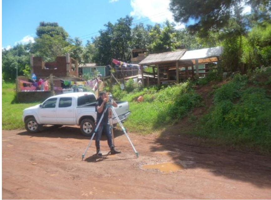
Figura 4.20. Nivelación de la estación total
