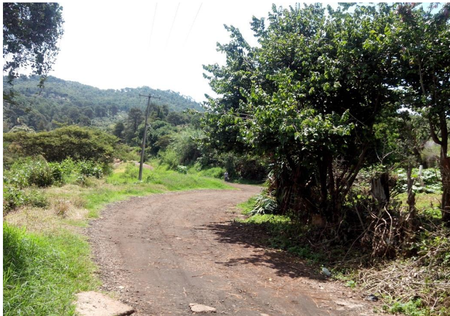
Figura 4.13. Curva prolongada en el eje del camino.
