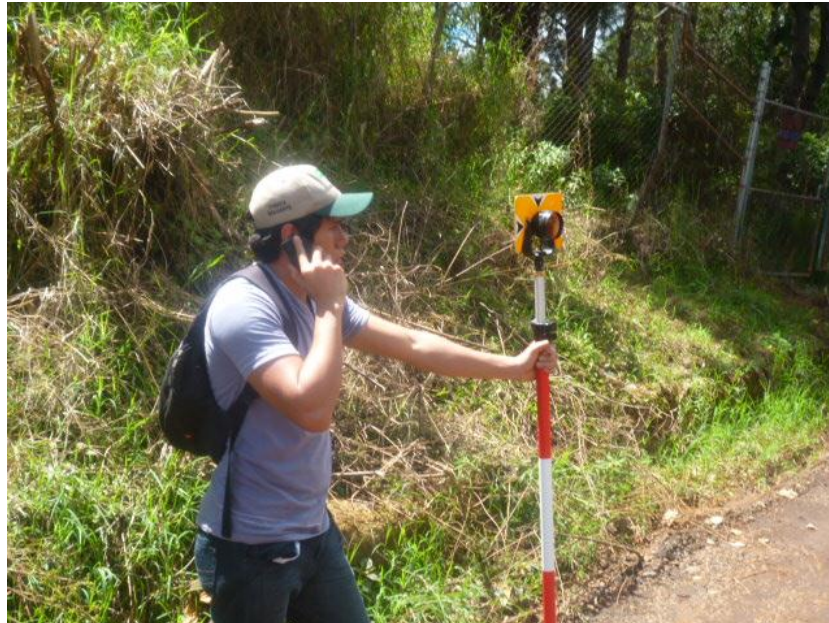
Figura 4.23. Comunicación entre balicero y estación total a través del uso de radios
