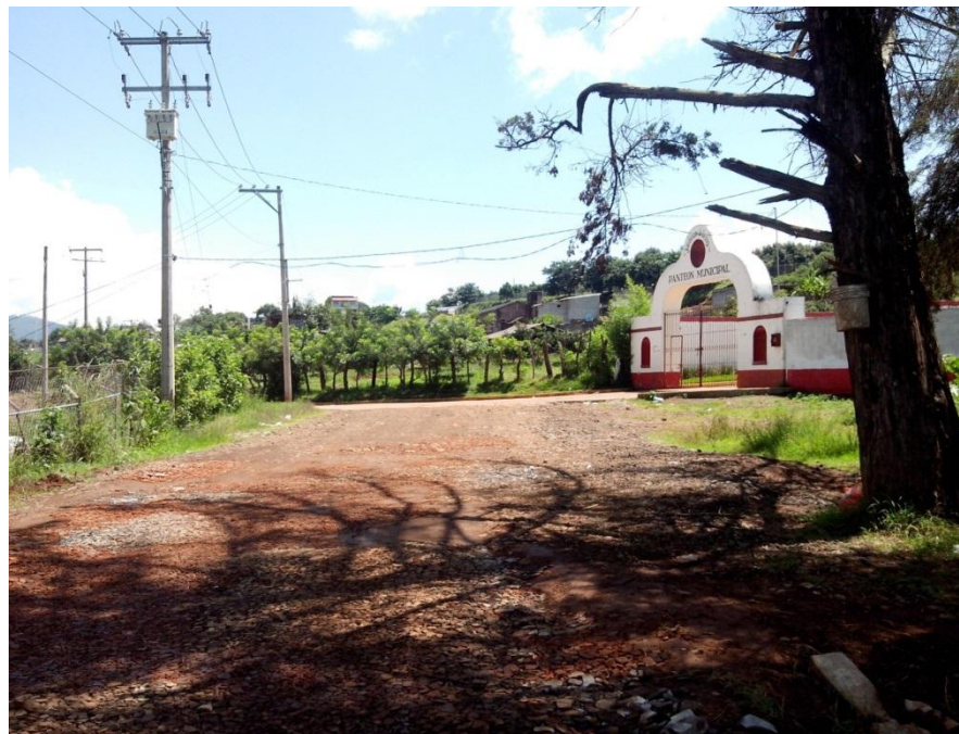
Figura 4.17. Km 1+625 del tramo en estudio, conexión al panteón municipal “Jardines de la paz”.
