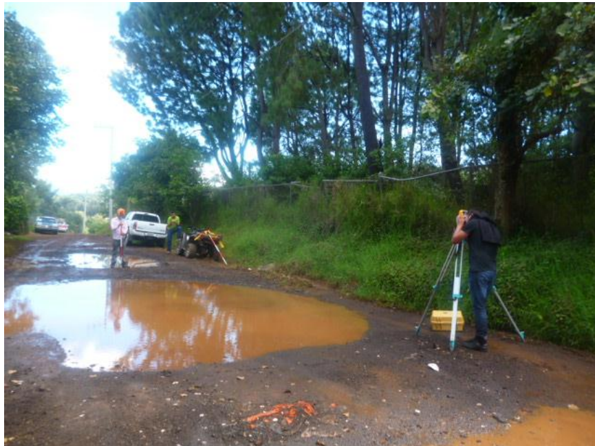
Figura 4.21. Toma de puntos sobre el eje del camino
