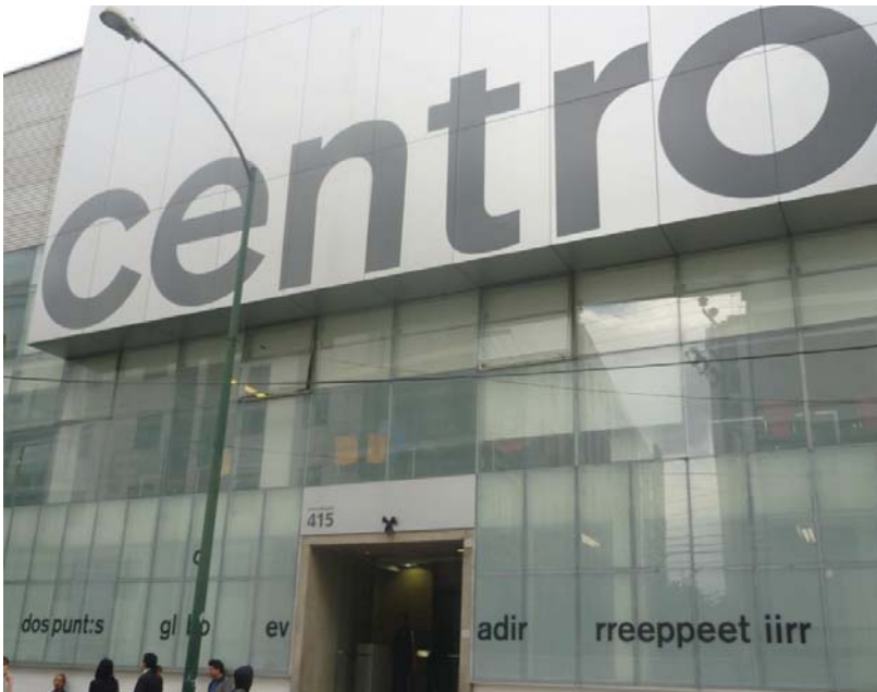
-Fachada principal de la institución
