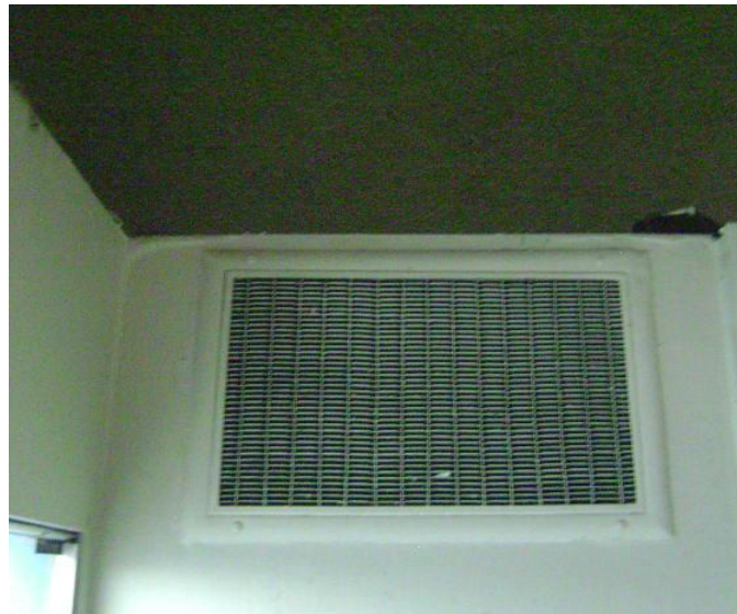
Instalación de aire acondicionado
