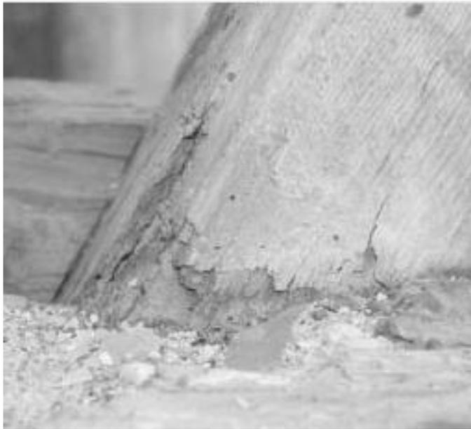
Imagen 2.7.- Cabeza de viga en desintegración.
