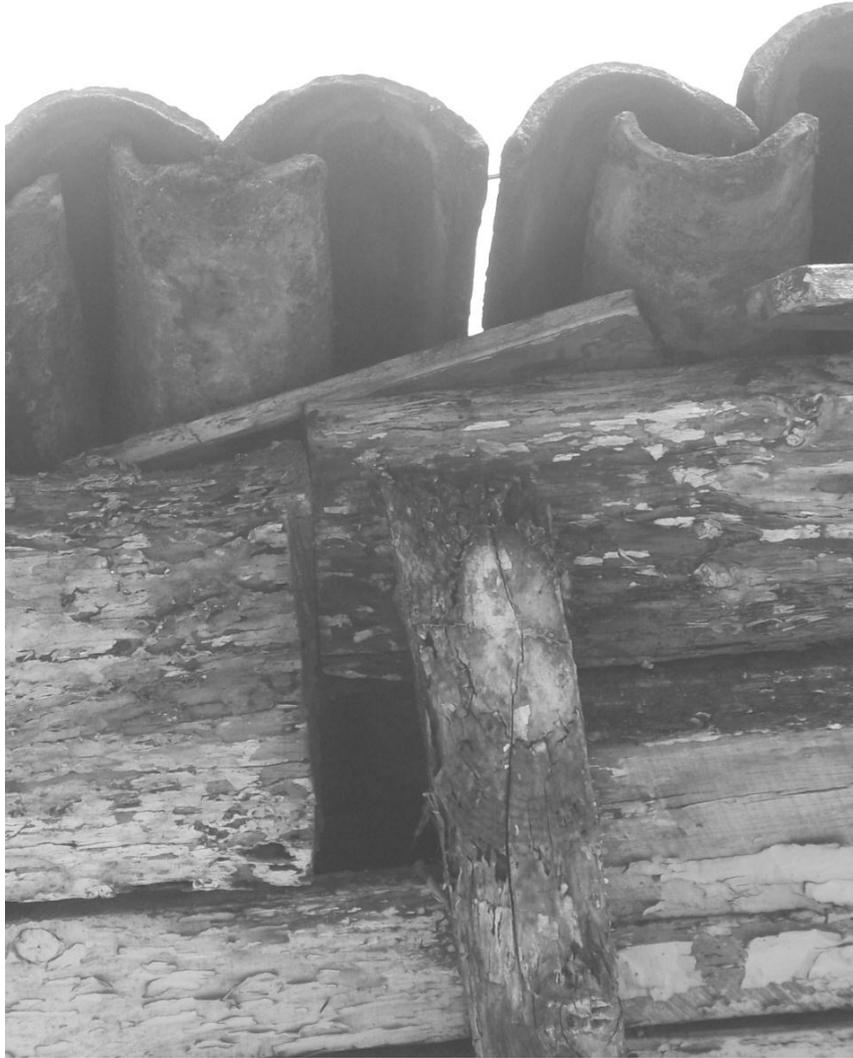
Fotografía 3.5.- Unión de estructura de madera a las tejas de barro.
