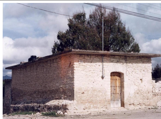
Vivienda híbrida: muros de piedra caliza y loza horizontal de concreto armado.
