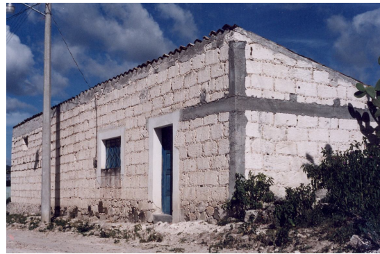
Vivienda híbrida: muros de piedra caliza con "refuerzos" de concreto armado.
