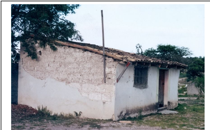
b) Vivienda de adobe y techumbre de teja de barro.
