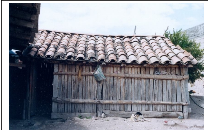
d) Vivienda de qurote y techo de teja.
