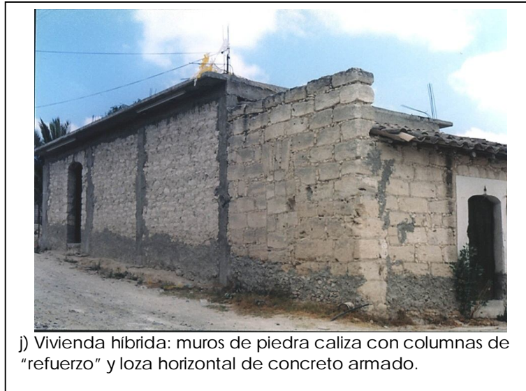
j) Vivienda híbrida: muros de piedra caliza con traves y columnas de "refuerzo" y loza horizontal de concreto armado.
