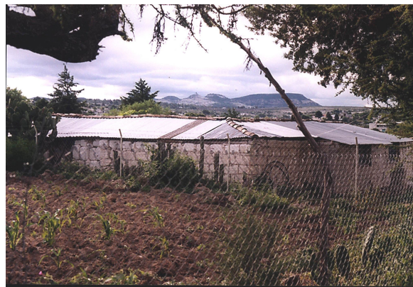
Vivienda híbrida: muros de piedra caliza con láminas de metal galvanizado en techumbre.
