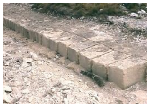
Corte de piedra caliza en bloques dimensionados: “piedra cortada”.
