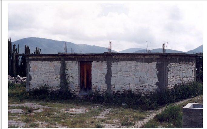
j) Vivienda híbrida: muros de piedra caliza con traves y columnas de "refuerzo" y loza horizontal de concreto armado.
