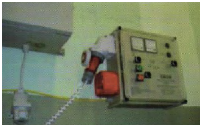
Fig. 21 Transformador para las pinzas eléctricas de aturdimiento. Manual de Bienestar Animal para operarios de Matanza en Rastros. SAGARPA (2013).
