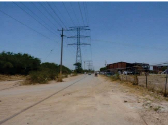
TORRES DE ALTA TENSIÓN. UBICADAS SOBRE EL BOULEVARD PADRE JORGE VERTIZ CAMPERO.
