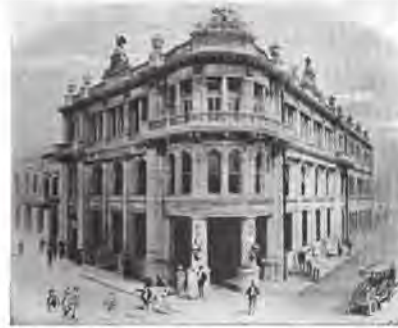
Banco Mercantil de Monterrey.
