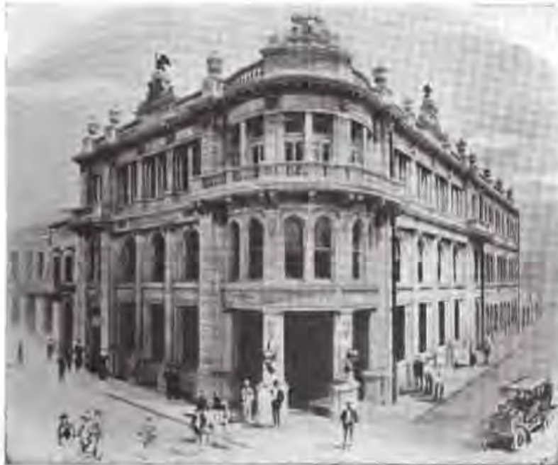
Banco Mercantil de Monterrey.
