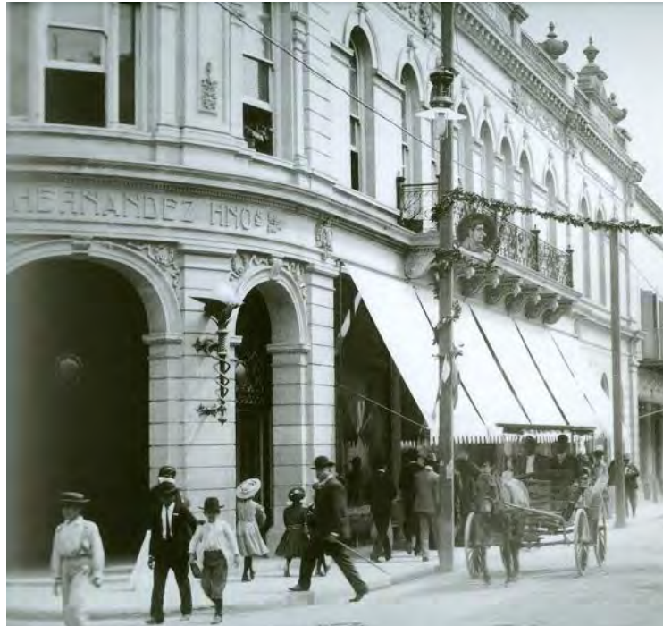
Imagen 87: Transeúntes por la calle Morelos. Monterrey, Nuevo León 1905
