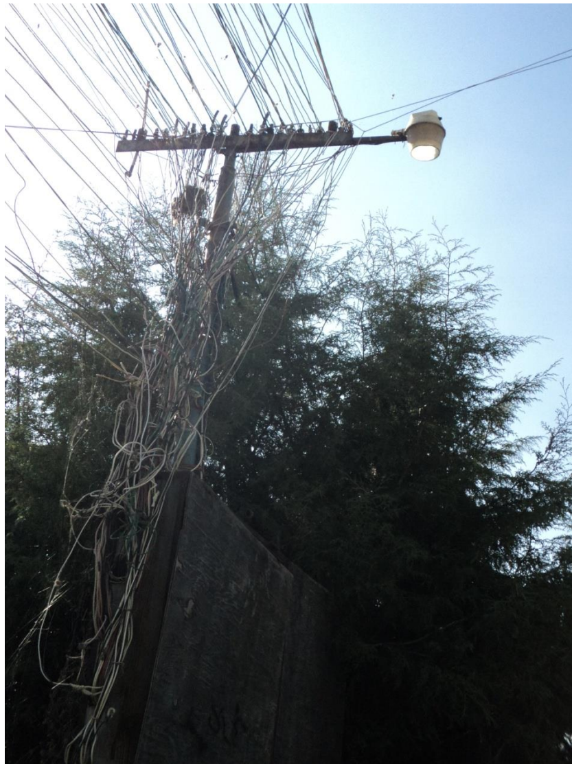
Imagen 4.5. Adecuación de la energía eléctrica en Nushtla
