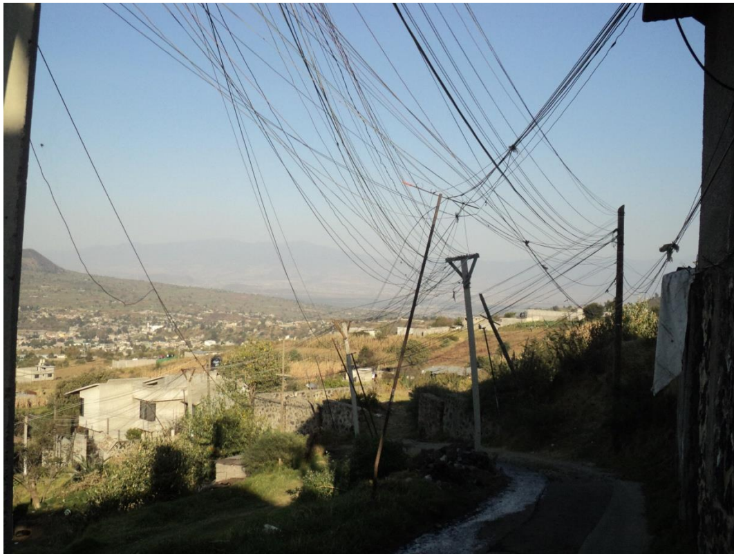
Imagen 4.4. Adecuación de la energía eléctrica en San Juan
