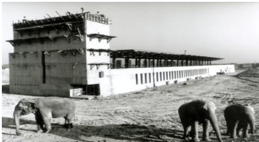
Imagen 15.- Construcción de "FARO ORIENTE".
