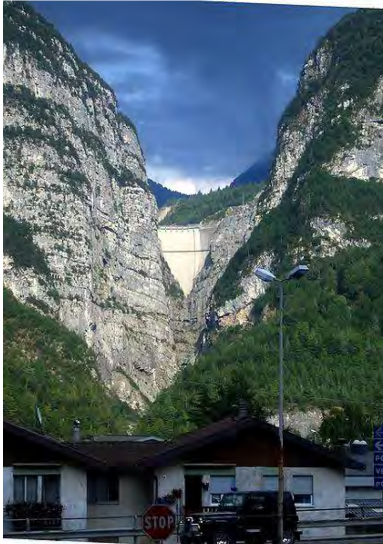
Figura 2.14 Vista de la Presa Vajont desde la ciudad de Longarone
