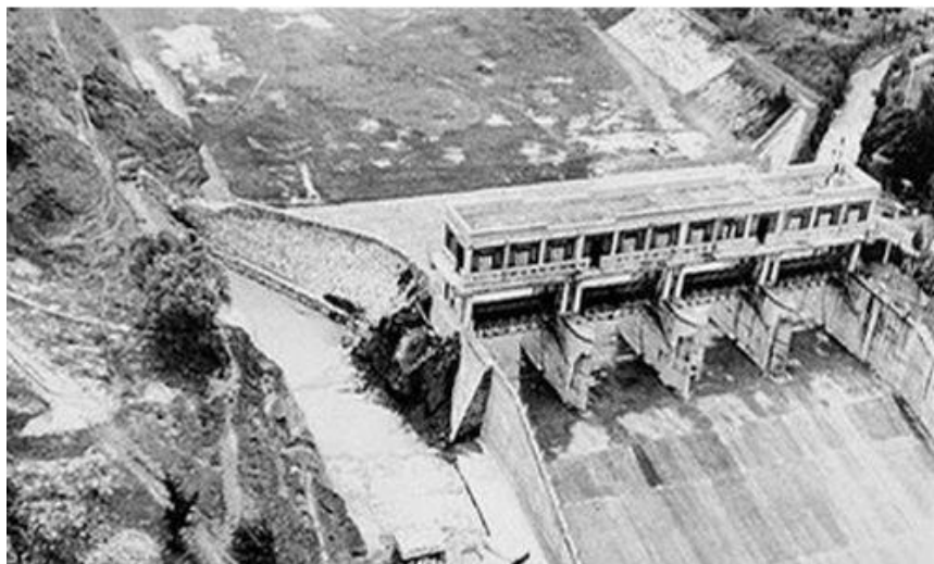
Figura 1.38 Se aprecia la obra de excedencias de una de estas presas. Imagen obtenida de http://chillopedia.com/interesting/top-15-worst-dam-disasters-ever/
