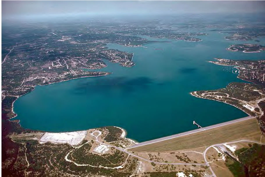
Figura 1.37 Vista de Canyon Lake en 2007. Imagen obtenida de http://commons.wikimedia.org/wiki/File:USACE_Canyon_Lake_and_Dam_Texas.jpg
