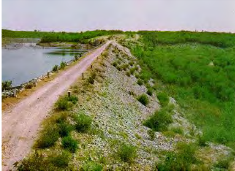
Figura 1.46 Cortina de la Presa La Escondida (Marengo, 2011)
