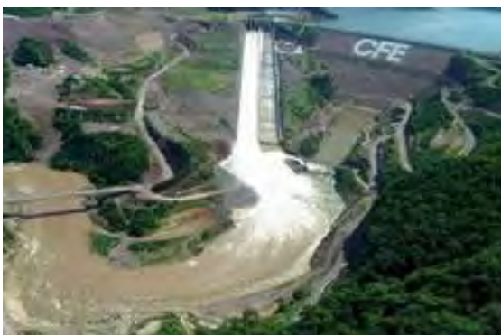
Figura 1.29 Vertedor en canal de la presa El Cajón, ubicada en el Estado de Nayarit.
