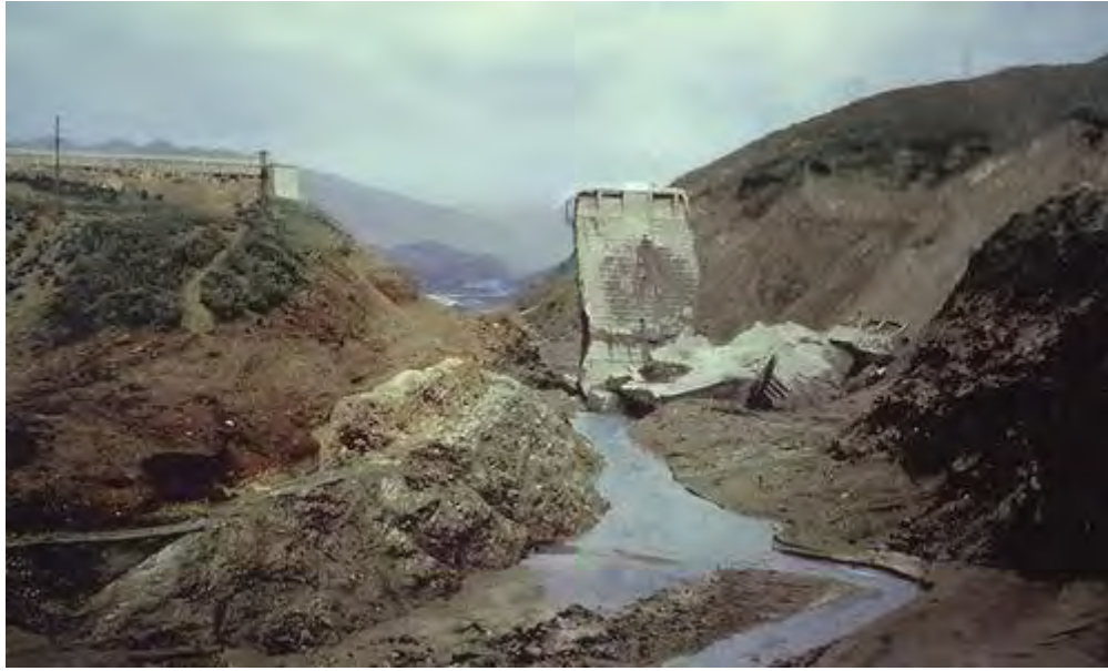
Figura 1.42 Falla en la cortina de la presa de St. Francis. Imagen obtenida de http://chillopedia.com/interesting/top-15-worst-dam-disasters-ever/
