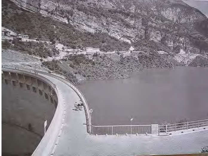
Figura 2.5 Corona de la Presa Vajont justamente después de su inauguración, en donde se muestra el puente que se construyó sobre la corona de la presa (1960)
