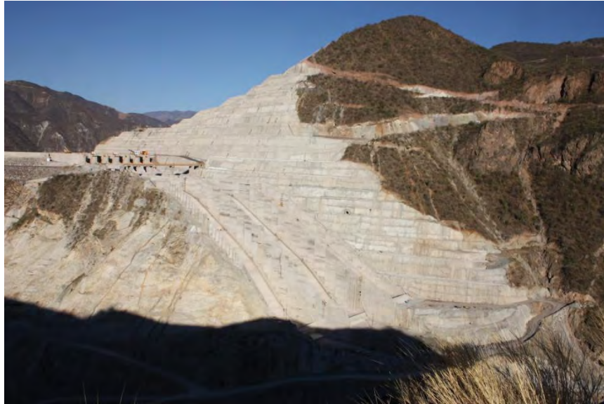
Figura 1.18 Obra de Excedencia de la C. H. La yesca. La característica de este vertedor contiene tres canales y al final de cada cana se puede apreciar la estructura terminal de salto de esquí. (Fuente Propia)
