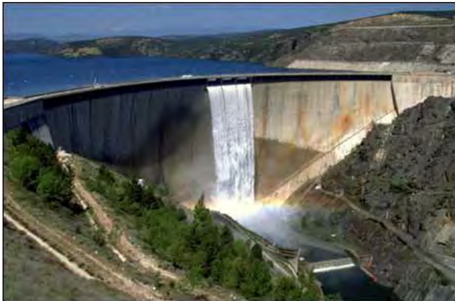
Figura 1.24 Presa El Atazar de doble curvatura. Ubicada en España. En la imagen se puede apreciar la operación de la obra de excedencia. (Murillo, 2012)
