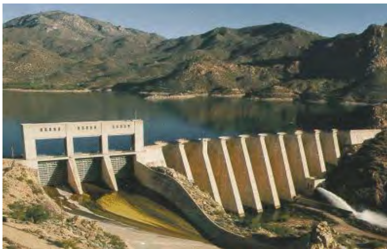
Figura 1.10 Se pueden apreciar en la imagen una presa que está conformada por 9 bóvedas con contrafuertes. (Villarino, 2006)
