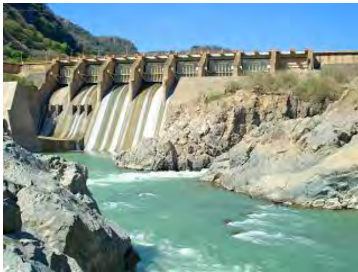
Figura 1.49 Cortina de la presa La Venta
