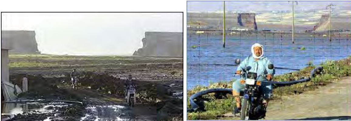
Figura 1.39 Se puede apreciar la falla en la cortina Zeyzoun. (Marengo, 2011) y http://news.bbc.co.uk/hi/spanish/news/newsid_2027000/2027629.stm
