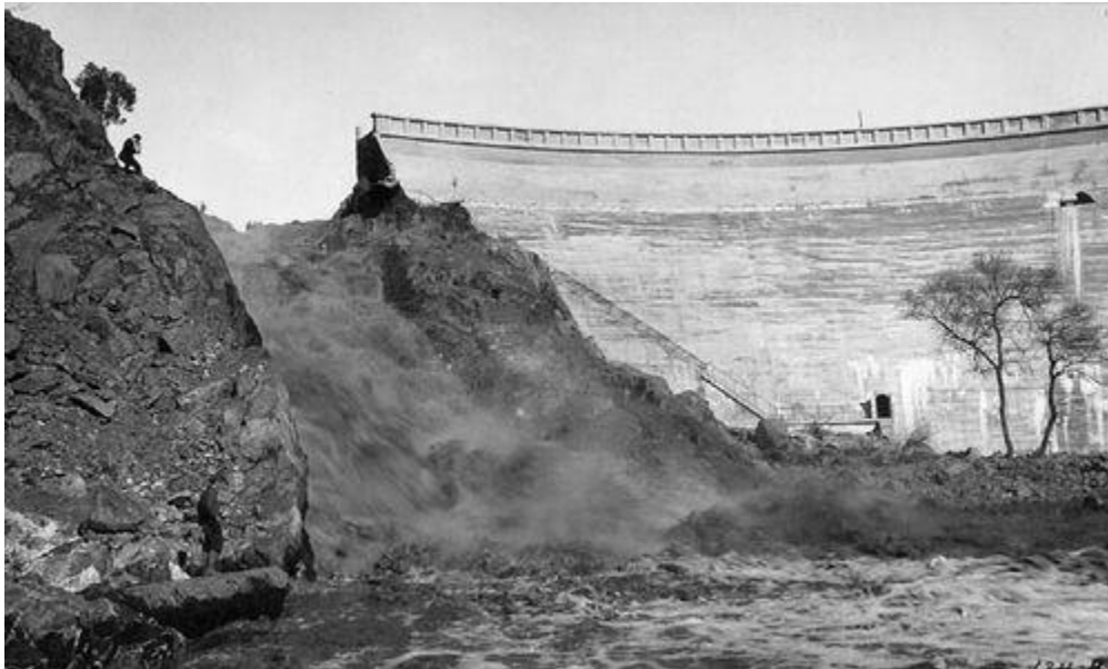
Figura 1.36 Desborde que se presentó en la presa Lower Otay. Imagen obtenida de http://chillopedia.com/interesting/top-15-worst-dam-disasters-ever/
