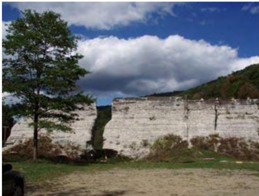
Figura 1.41 Falla en la presa Austin. (Marengo, 2011).
