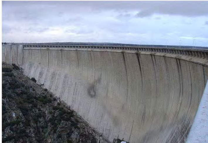
Figura 1.9 Presa de arco de doble curvatura. Se puede observar con claridad la forma de la bóveda; de aquí por qué recibe también este nombre. (Villarino, 2006)
