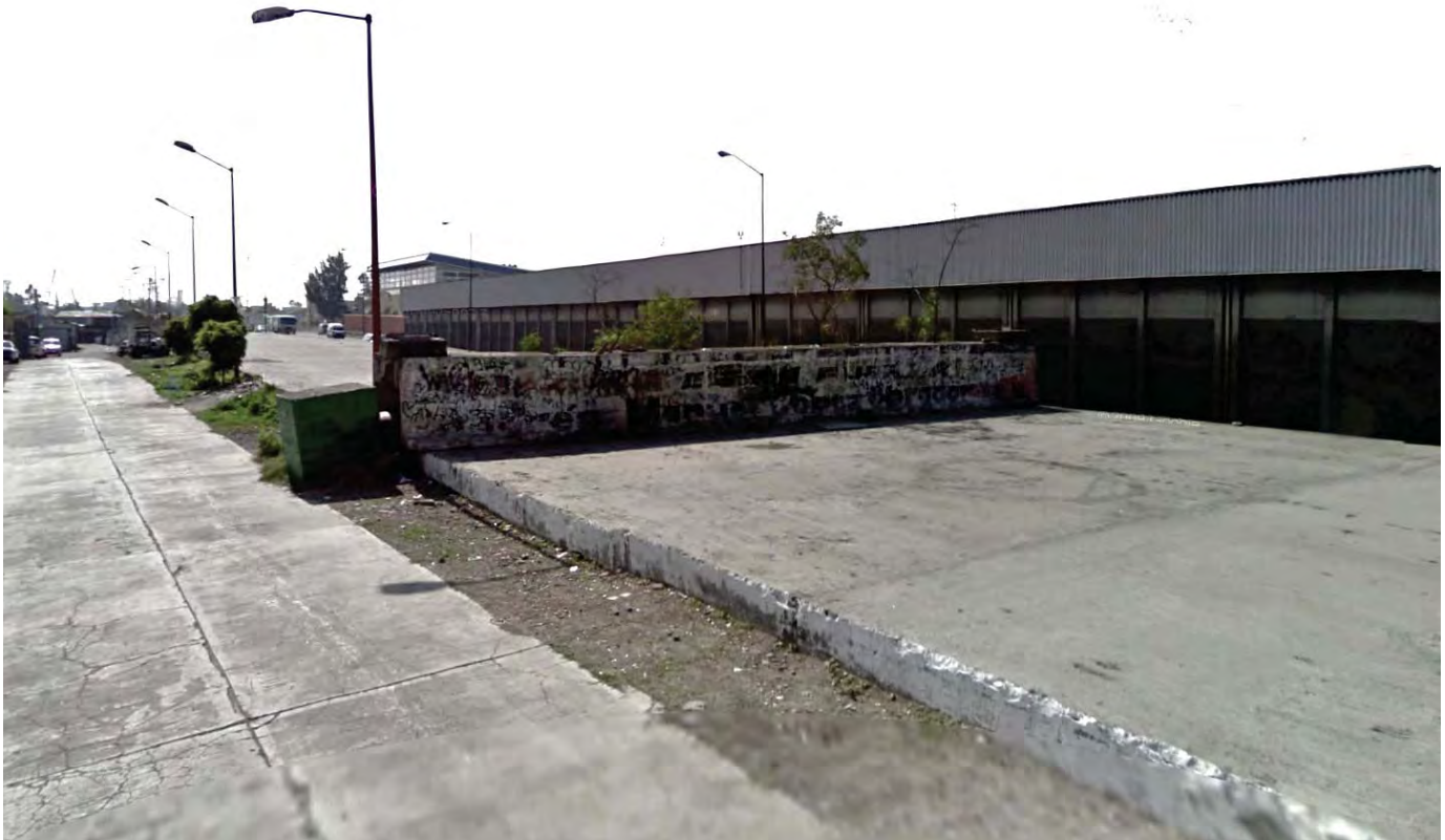
Imagen 168. Vista de una tubería que obstruye el paso sobre el Río Churubusco entubado. Google maps.
