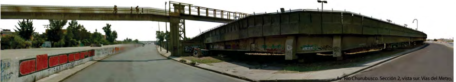
Av. Río Churubusco. Sección 2, vista sur. Vías del Metro.
