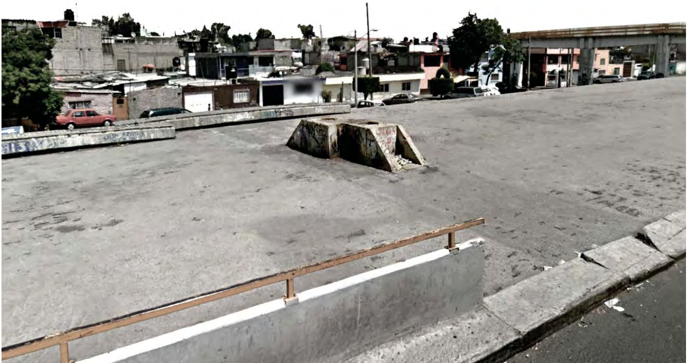
Imagen 162. Vista de una chimenea sobre el Río Churubusco entubado. Google maps.
