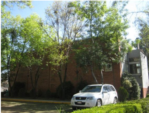
a) Fachada oeste del laboratorio
