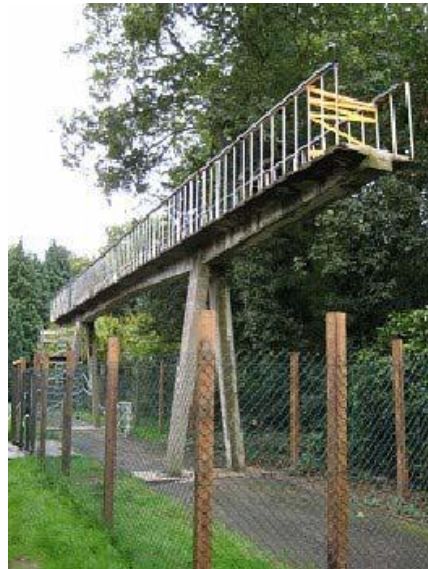
Figura 2.4. Puente peatonal estudiado (Barton et al., 2011)
