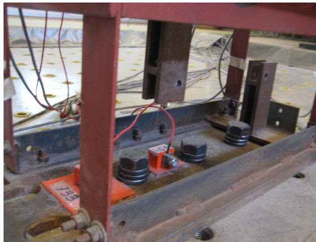
Figura 4.1. Fijación de la estructura a la plataforma de la mesa vibradora
