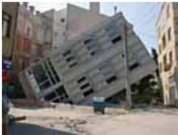
Figura 4.5 Edificio Volcado Debido a la Licuación del Suelo
