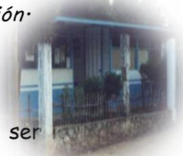
Por las características del edificio tanto en sus acabados los cuales distan mucho de ser adecuados para un edificio destinado a la salud solo con mencionar que el techo es a base de lámina y dejando de lado un poco lo constructivo debemos hacer énfasis en la falta de espacios ya que la mayoría de estos podríamos decirlo así multiusos se determinó demolerlo para poder dar paso a nuestro proyecto.
