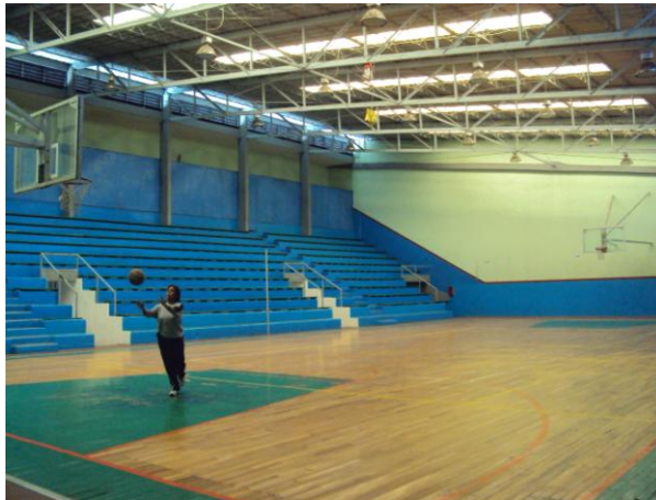
Vista interior y estructura de cubierta
