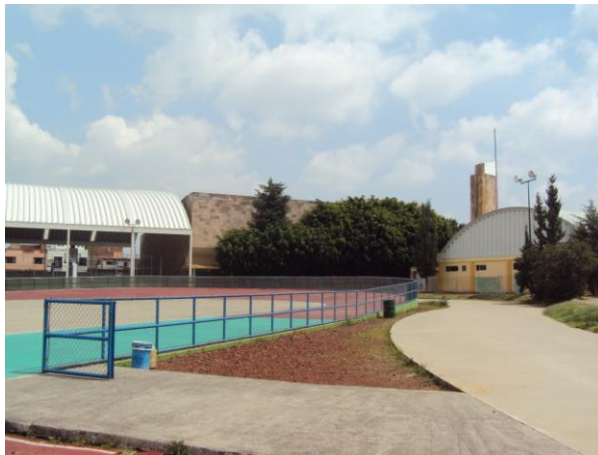
Pista de patinaje, auditorio al fondo a la derecha alberca semi olímpica y canchas de usos múltiples con cubierta.
