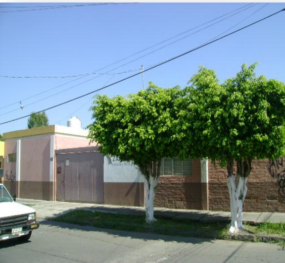
Fachada principal del Albergue de Zamora.
