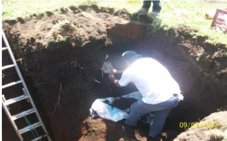
Imagen 6.11.- Obtención de las muestras alteradas del sondeo tres.
