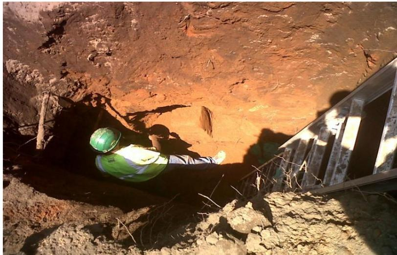
Imagen 6.12.- Obtención de la muestra inalterada del sondeo tres.
