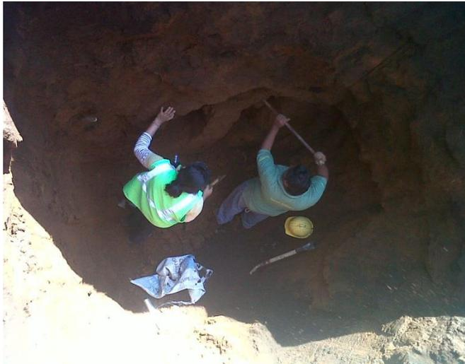
Figura 4.3.- Obtención de muestras integrales.
