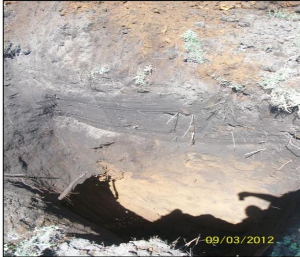
Figura 4.1.- Sondeo a cielo abierto.
