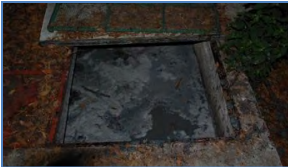
FOTO 8 Y 9. DEPÓSITO DE AGUAS JABONOSAS SATURADO DE NATAS; EXTRACCIÓN DE NATAS (CONGLOMERADOS DE GRASAS) PROVENIENTES DE LAS AGUAS JABONOSAS.
