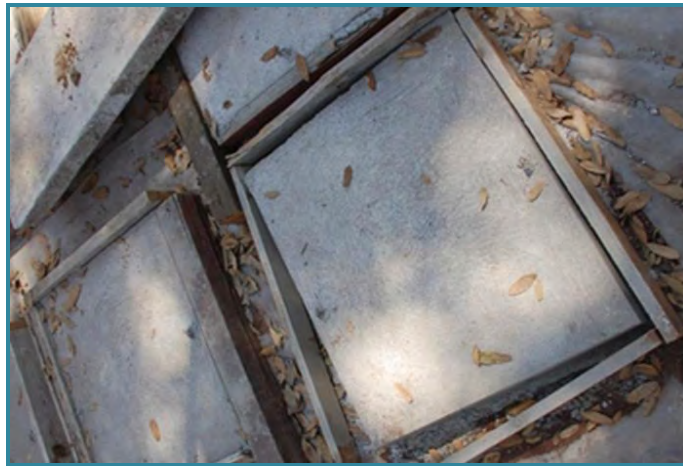
FOTO 26. CONSTRUCCIÓN DE REGISTROS PARA EL SELLADO DE LAS TUBERÍAS DEL SISTEMA DE ALIMENTACIÓN DEL SUTRANE.
