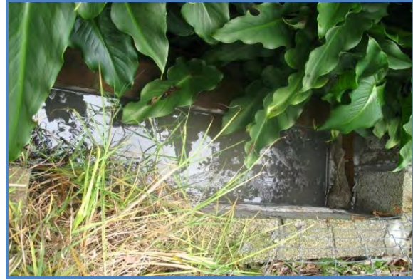
FOTO 3 Y 4. ACUMULACIÓN DE HOJARASCA Y NATAS EN EL DEPÓSITO DE AGUAS JABONOSAS; INVASIÓN DE MALEZAS EN LA CANALETA DE ENTRADA.
