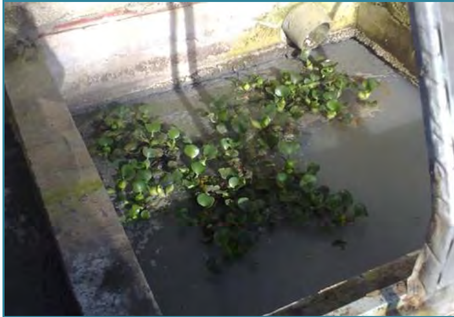
FOTO 10. VEGETACIÓN (LIRIO ACUÁTICO) DENTRO DEL DEPÓSITO DE AGUAS JABONOSAS.
