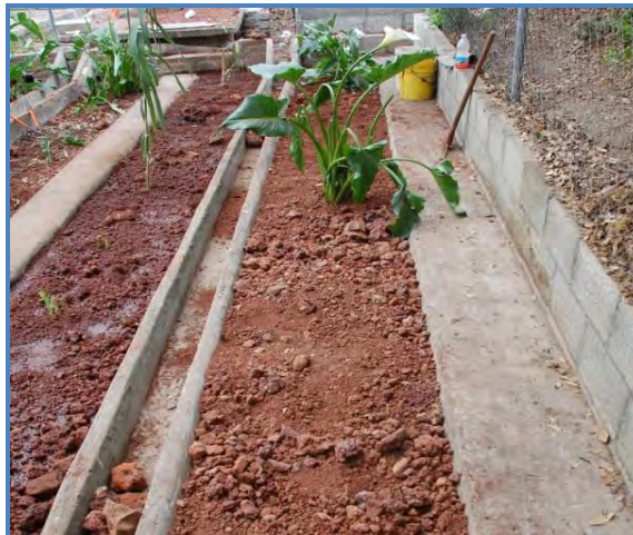
FOTOS 16 Y 17. COLOCACIÓN DE TEZONTLE ROJO EN LAS CANALETAS DEL HUMEDAL
