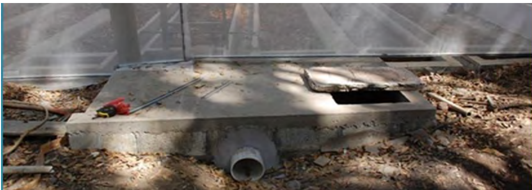
FOTO 21. DEPÓSITO FINAL DE ALMACENAMIENTO DE AGUAS TRATADAS.
