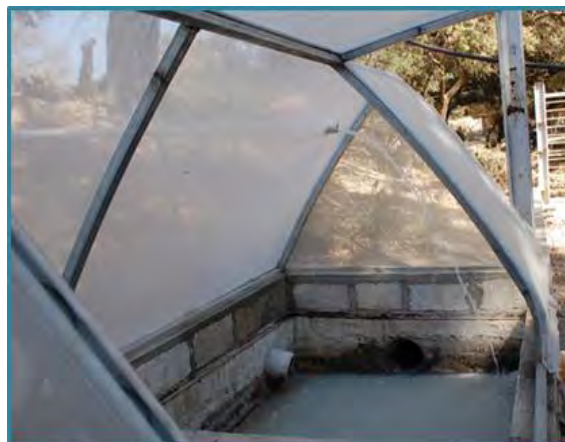
FOTO 8 Y 9. INVERNADERO Y MICROINVERNADERO EN EL SUTRANE. SISTEMA DE CAÍDA LIBRE DENTRO DEL DEPÓSITO DE AGUAS JABONOSAS.
