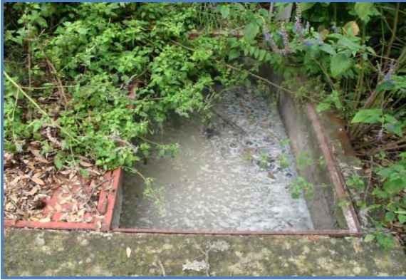
FOTO 3 Y 4. ACUMULACIÓN DE HOJARASCA Y NATAS EN EL DEPÓSITO DE AGUAS JABONOSAS; INVASIÓN DE MALEZAS EN LA CANALETA DE ENTRADA.
