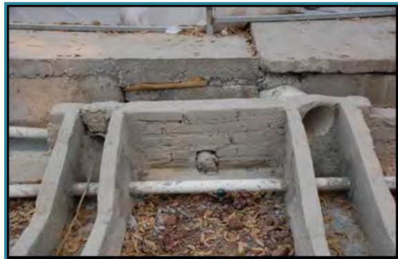
FOTO 12 Y 13. SE MEJORÓ EL SISTEMA DE DESAGÜE DEL SUTRANE CON LA RECONSTRUCCIÓN DE CANALETAS DE AGUAS PLUVIALES.
