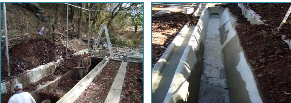
FOTO 17 Y 18. LIMPIEZA Y REPARACIÓN DE LAS CANALETAS DEL HUMEDAL.
