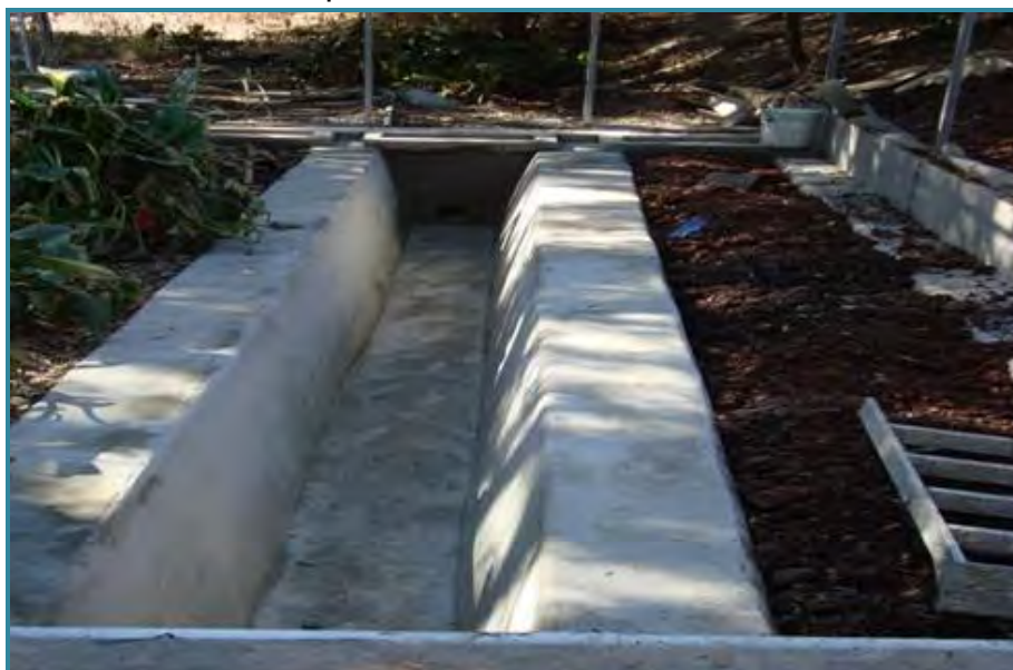
FOTO 19. CONSTRUCCIÓN DE PASILLOS DE CONCRETO ENTRE LAS CANALETAS DEL HUMEDAL.
