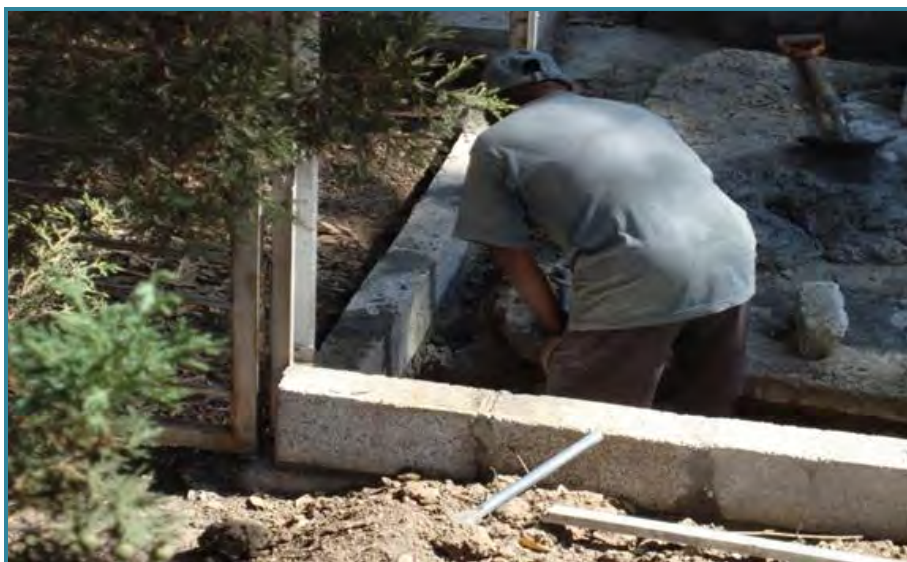
FOTO 14. ELEVACIÓN DE PAREDES DE CONTENCIÓN
