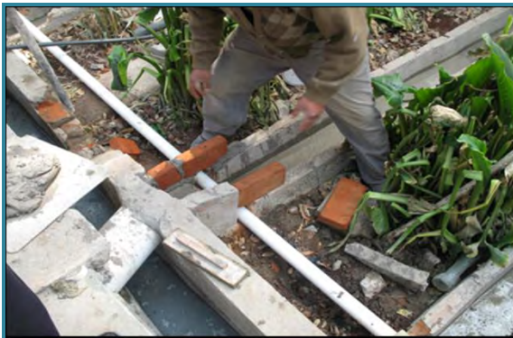
FOTO 12 Y 13. SE MEJORÓ EL SISTEMA DE DESAGÜE DEL SUTRANE CON LA RECONSTRUCCIÓN DE CANALETAS DE AGUAS PLUVIALES.
