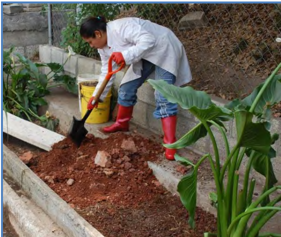
FOTOS 16 Y 17. COLOCACIÓN DE TEZONTLE ROJO EN LAS CANALETAS DEL HUMEDAL
