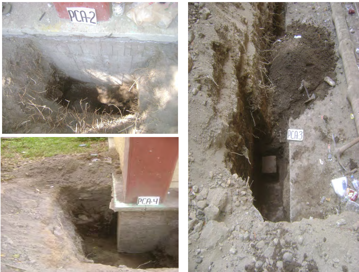
Fig. 25 Excavación de los pozos a cielo abierto realizados
