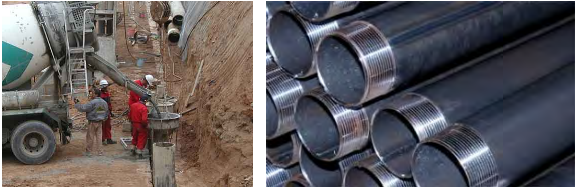
Fig. 57 Inyección de cemento por gravedad
