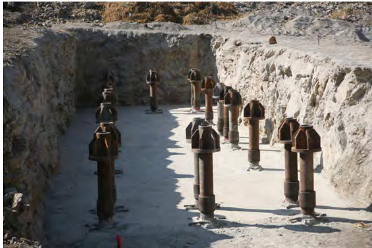
Fig. 58 Formación de bulbo de anclaje del micropilote
