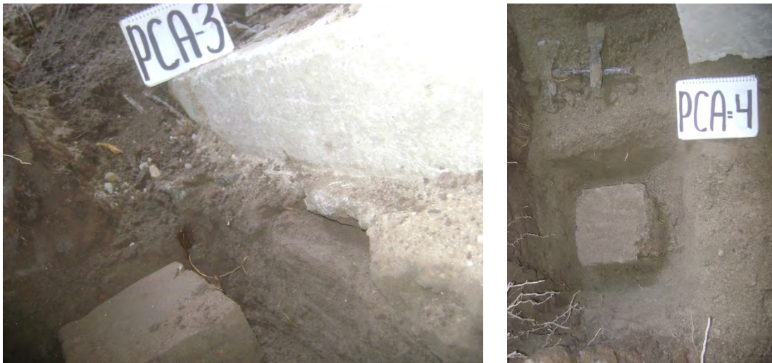
Fig. 26 Vista de muestra cúbica inalterada obtenida del pozo a cielo abierto No.3 y No.4
