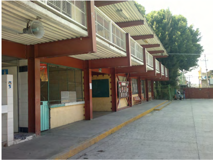
Fig. 14 Vista panorámica del Edificio A
