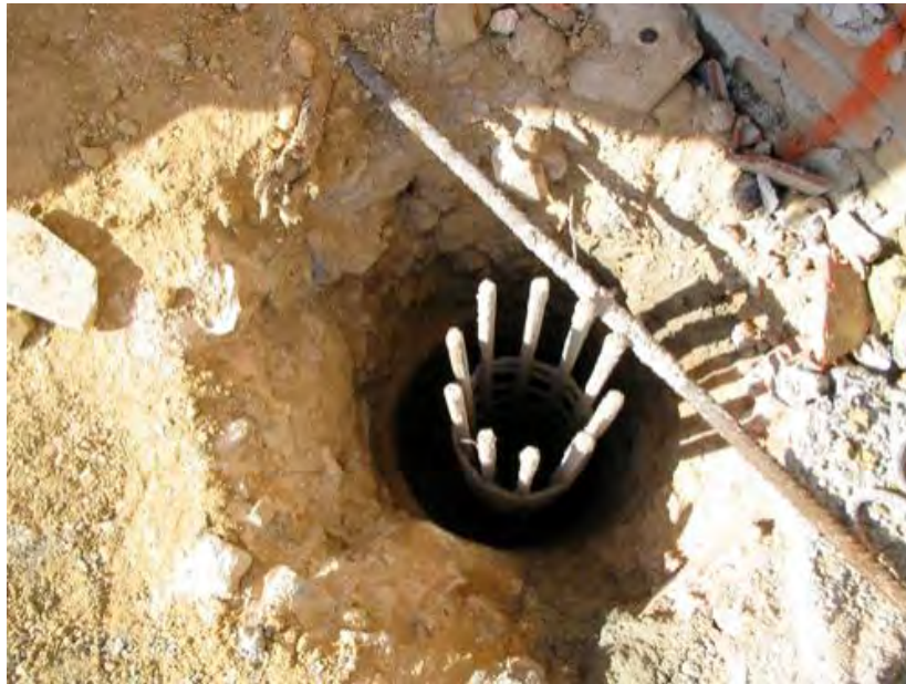
Fig. 56 Colocación de la armadura para micropilote
