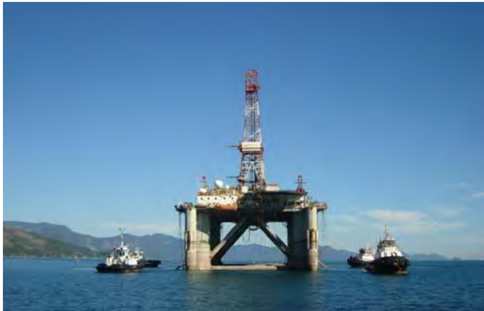
Fig. 2.3.- Plataforma de 2da generación Alaskan Star, Petrobras. Año de construcción 1976. Fuente: http://www.kepcorp.com
