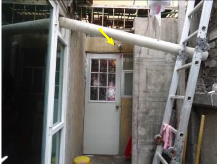
Figura 3.10 Vista del área 7.
