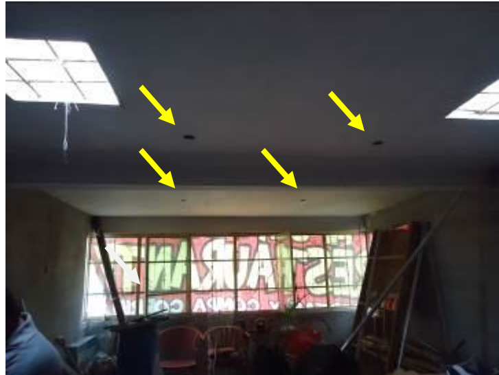
Figura 3.11 vista del área 8.
