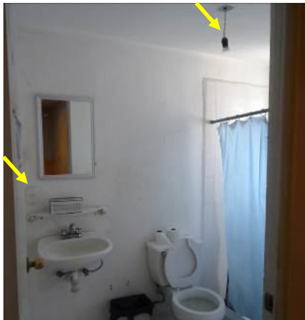
Figura 3.15 Vista del área 12.
