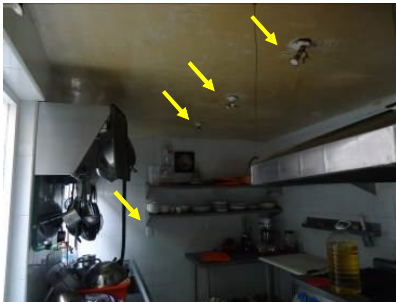
Figura 3.7 vista del área 4.
