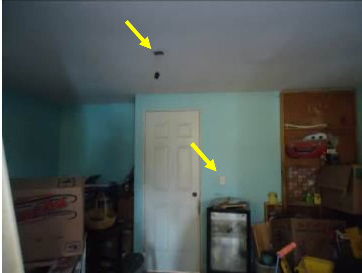
Figura 3.12 vista del área 9.
