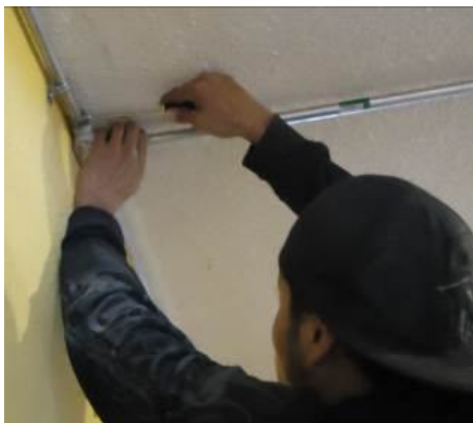
Figura 3.22 fijación de un conector para tubo galvanizado.
