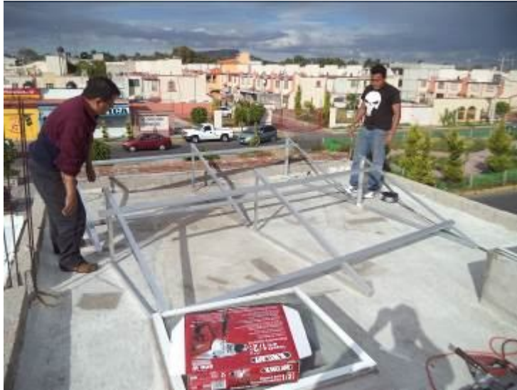
Figura 3.28 Armado de estructuras para módulos solares.
