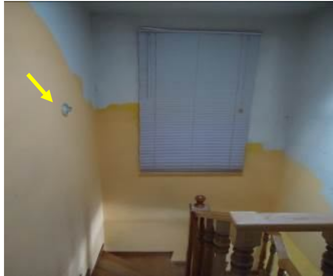
Figura 3.8 vista del Área 5.
