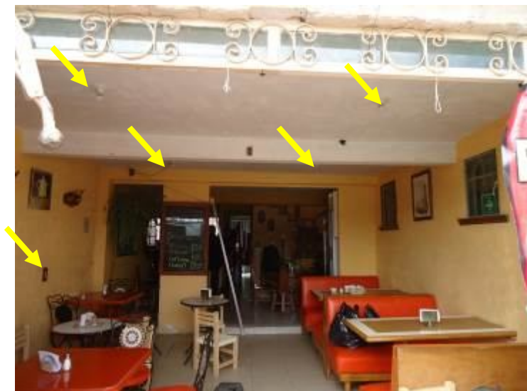
Figura 3.4 Vista del área 1.
