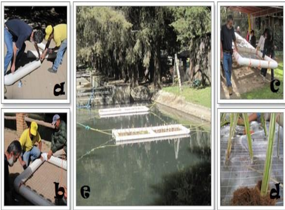
Figura 13 . Diseño de Humedales Flotantes (A) construidos con tubos de PVC y malla galvanizada (a y b), se colocaron cincuenta individuos por balsa (c, d y e), como sustrato se usó fibra de coco.
