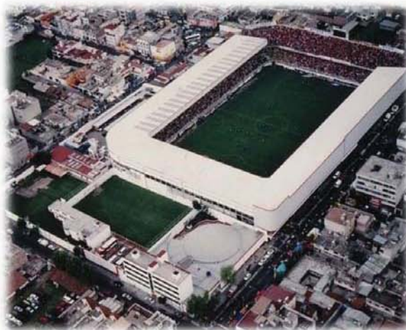
IMAGEN N° 23: Estado actual del estadio del Deportivo Toluca y sus alrededores
