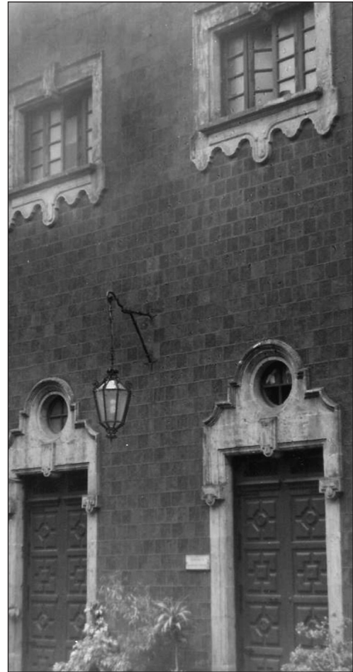
Fachada del hospital.
