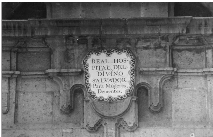
Detalle de fachada del hospital.
