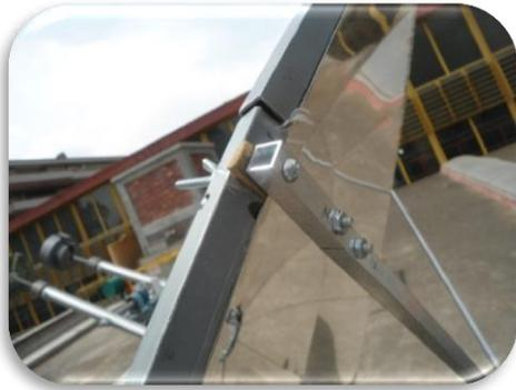
*Imagen 2.17. Brazo para fijar el receptor al concentrador*
