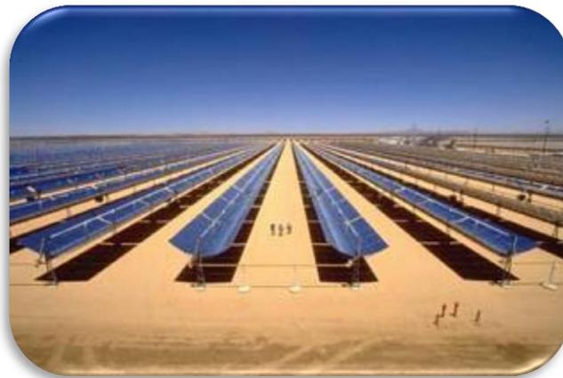
Imagen 1.18 Canales parabólicos de la planta SEGS, Desierto de Monjave en California, Estados Unidos [ Nextera energy resources, [www.nexteraenergyresources.com](http://www.nexteraenergyresources.com)]
