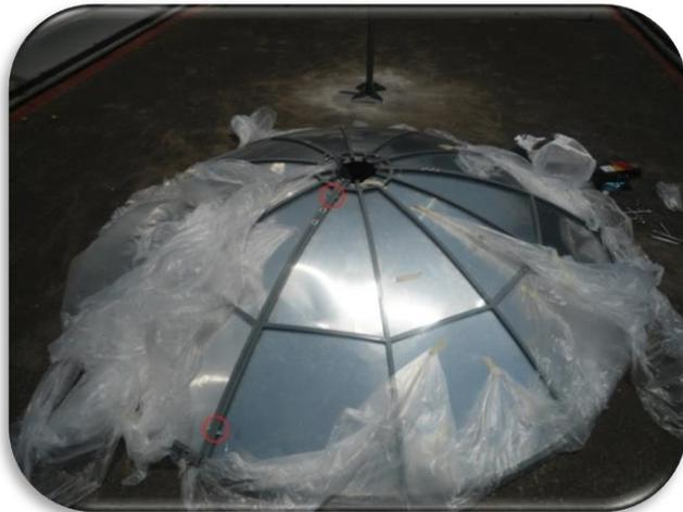
Imagen 2.9. Partes donde se fijan los segmentos
