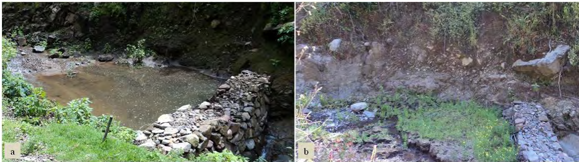
Figura 14. Presa de gavión que comienza a alterar el régimen hidrológico. A) Época de lluvias y B) Época de secas
