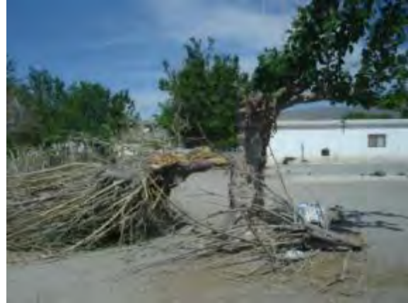
Se observan los daños causados por una tormenta reciente.
