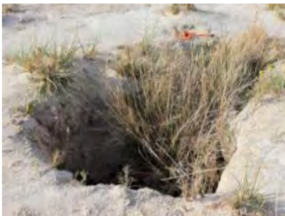
Uno de los hundimientos diferenciales, también llamados abras, que se encuentran cerca del predio y evidencian la escasez de agua en el sistema.
