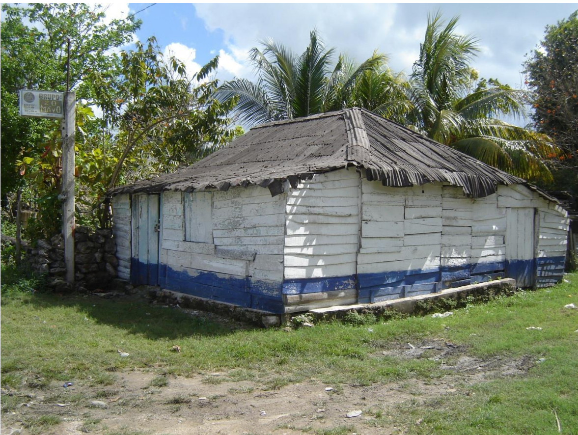
Fotografía 4. Fuente: Trabajo de campo, 9 de febrero de 2011.
