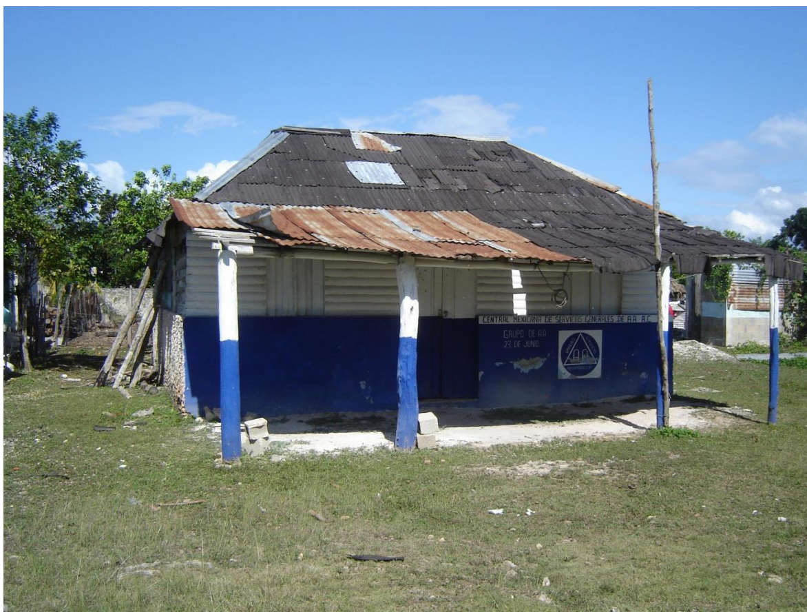
Fotografía 3. Fuente: Trabajo de campo, 9 de febrero de 2011.
