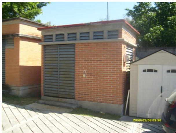
Figura 2.25 Caseta vista por fuera a la que se le entregará corriente por medio de un arreglo fotovoltaico.
