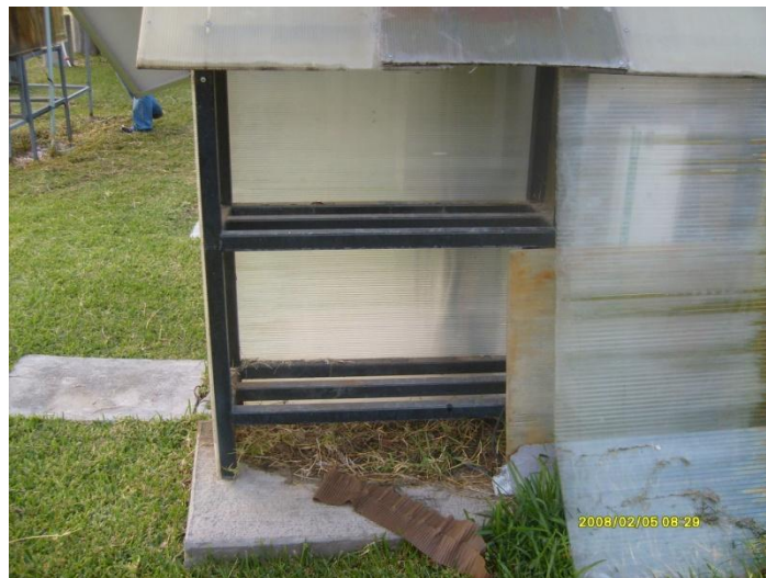
Figura 2.23 Caseta para montar el banco de baterías.
