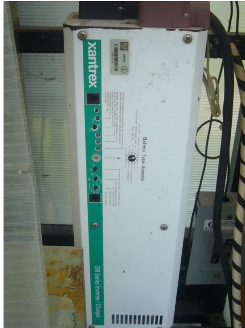
Figura 2.5 Inversor de la marca Xantrex DR1524.
