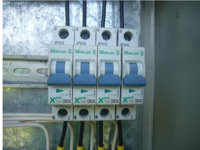
Figura 2.10 Interruptores de seguridad termo magnéticos Moeller Xpole C20-DC.
