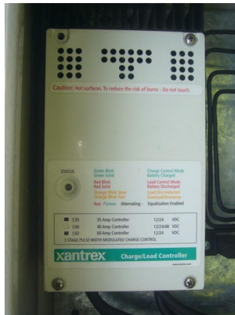
Figura 2.4 Controlador de baterías de la marca Xantrex modelo C-40.
