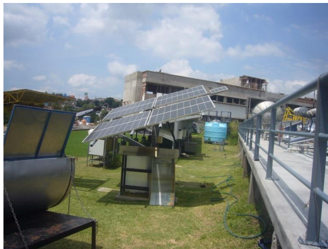
Figura 2.21 Lugar libre de sombras del panel fotovoltaico.
