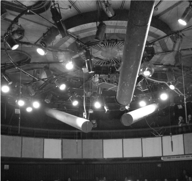
8. Vista desde la planta baja hacia la planta alta y la iluminación de la sala.
