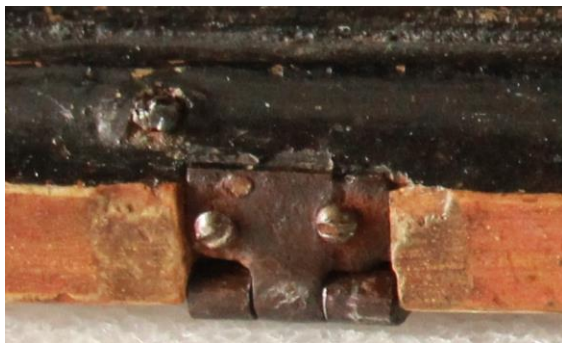
27a. Detalle de bisagra superior fijada con tornillos; y taquete arriba lado izquierdo.
