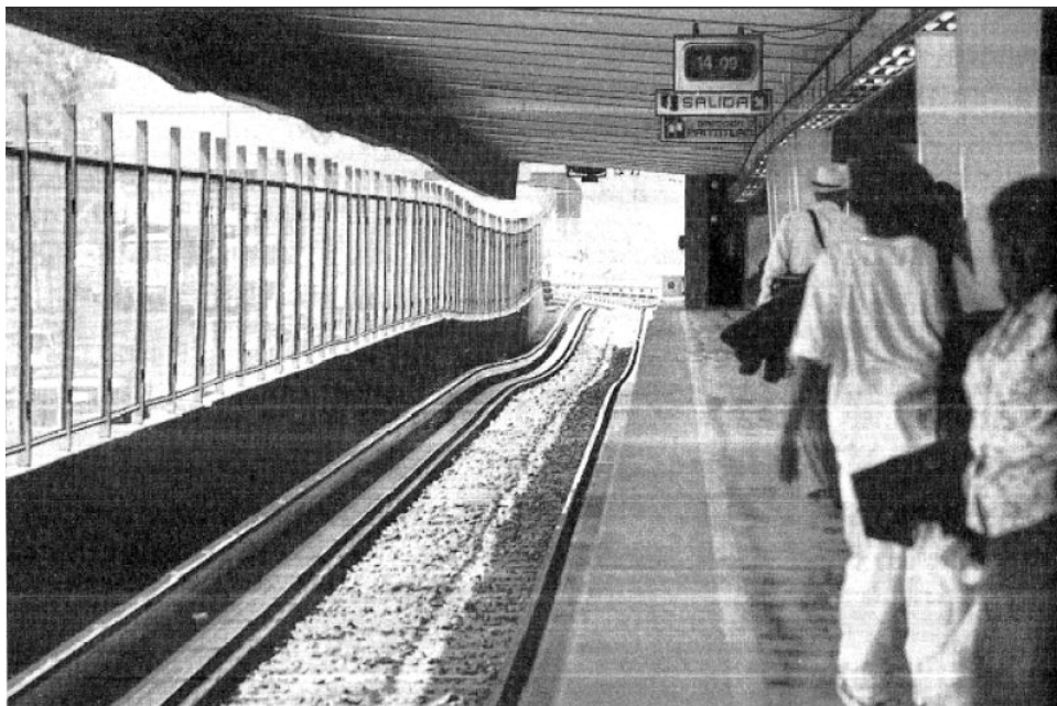
Ilustración 5.4 Vista interior de las vías.
