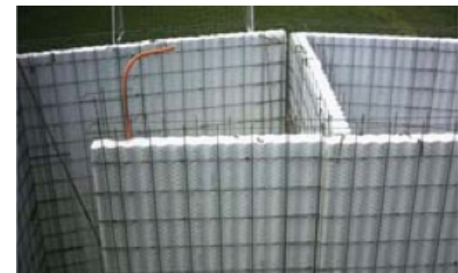
Figura 5. Láminas de “EPS” como aislante térmico en la construcción.
